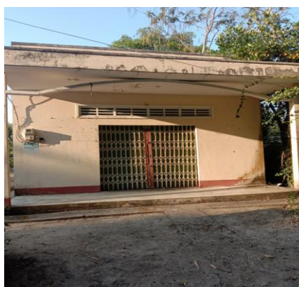
Nhà SHCD ấp Kiết Lập B
